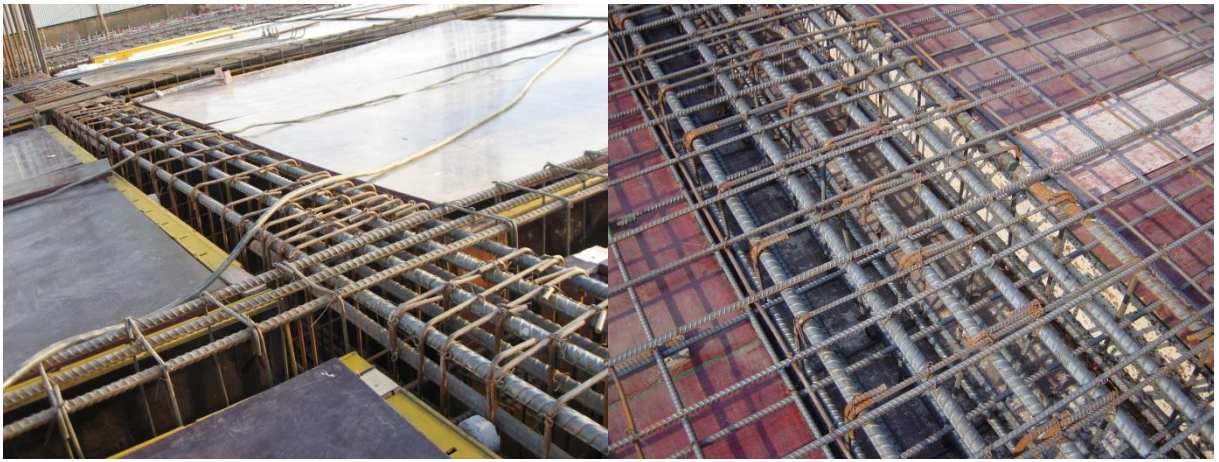
Hình 6. 27. Cấu tạo cốt thép trong dầm.
