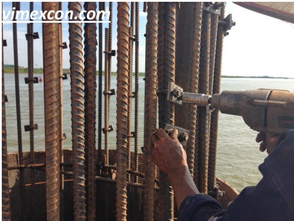
Hình 6. 55. Nối thép bằng U-bolt.
